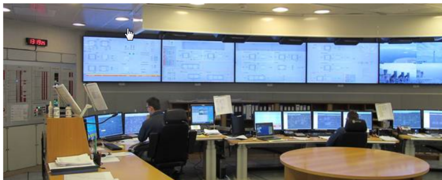
Operatørene har tilgang til rundt 70 000 signaler fra kontrollrommet. Foto: BP
